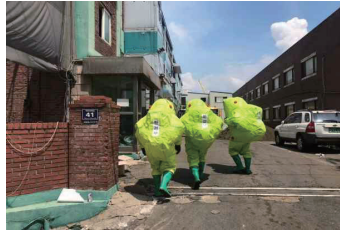
( 초기 방재 작업 및 오염도 측정 )
