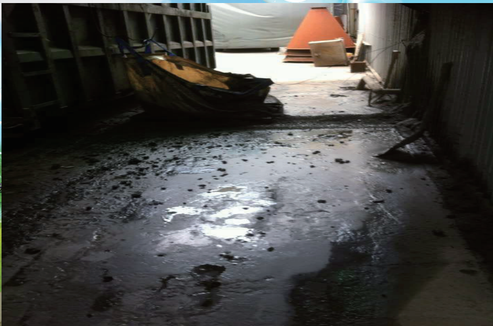
폐기물(소각재 침출수)을 부적정하게 보관하여 주변환경오염 유발
