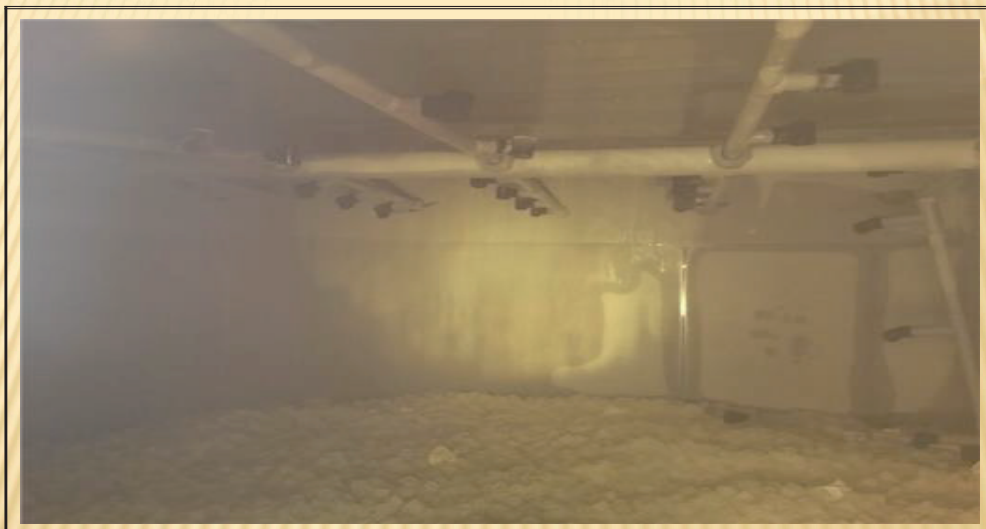
방지시설인 흡수시설에 세정수가 분사되지 않는 상태
