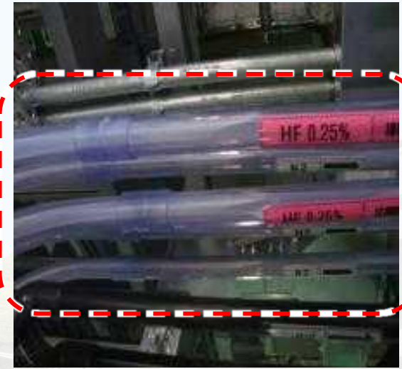
이중 배관 설치
