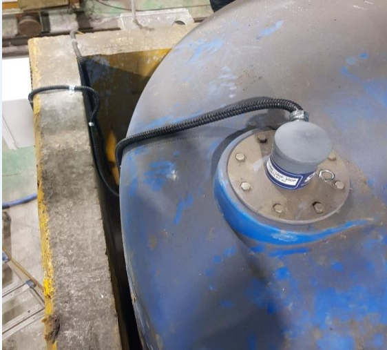
◎ 수위계 및 과충전방지 장치 관련 사진
