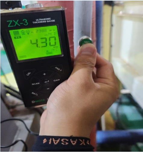
◎ 배관 두께 측정 관련 사진
