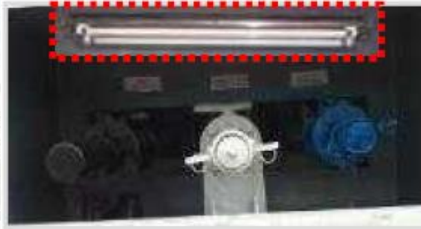
약품 주입구함 조명등 설치
