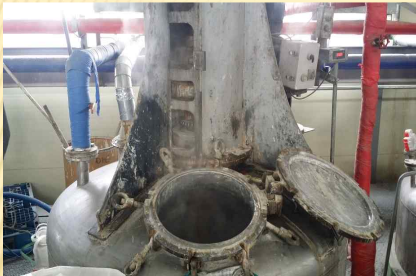
혼합시설 투입구 개방하여 작업
