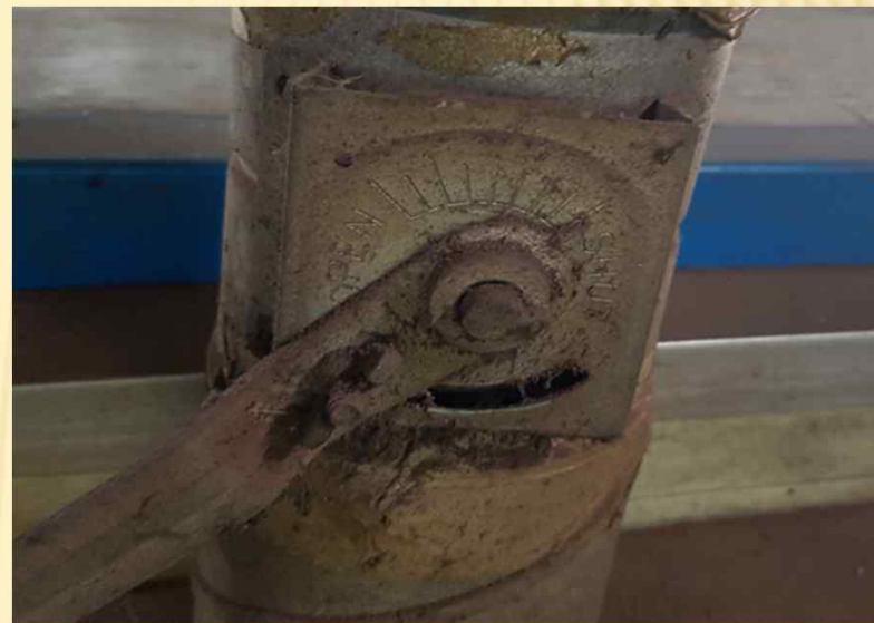
관로 멤퍼를 담은 상태로 작업
