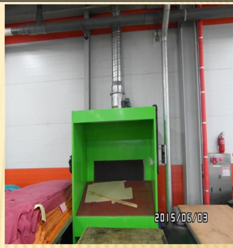
배출시설이 가동되지 않는 상태에서 공기가 방지시설로 흡입되는 상태
