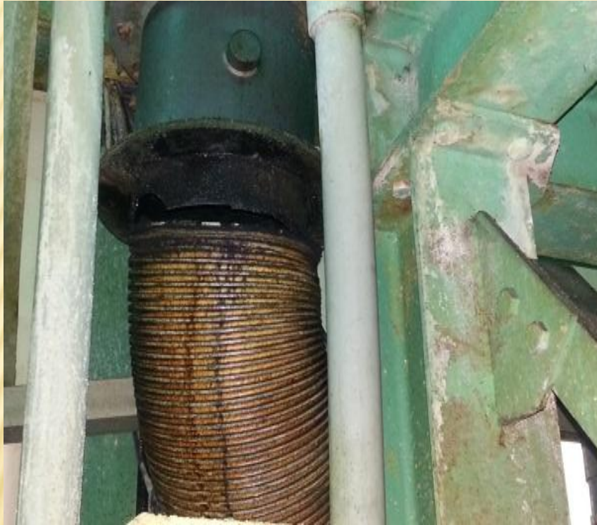
덕트 연결 부위 파손
