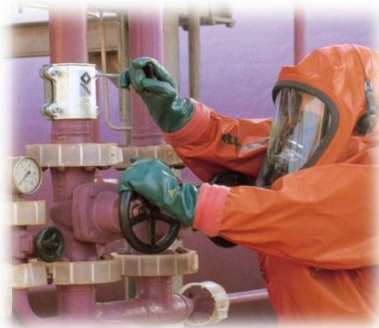
밸브차단 누출방지장비 설치
