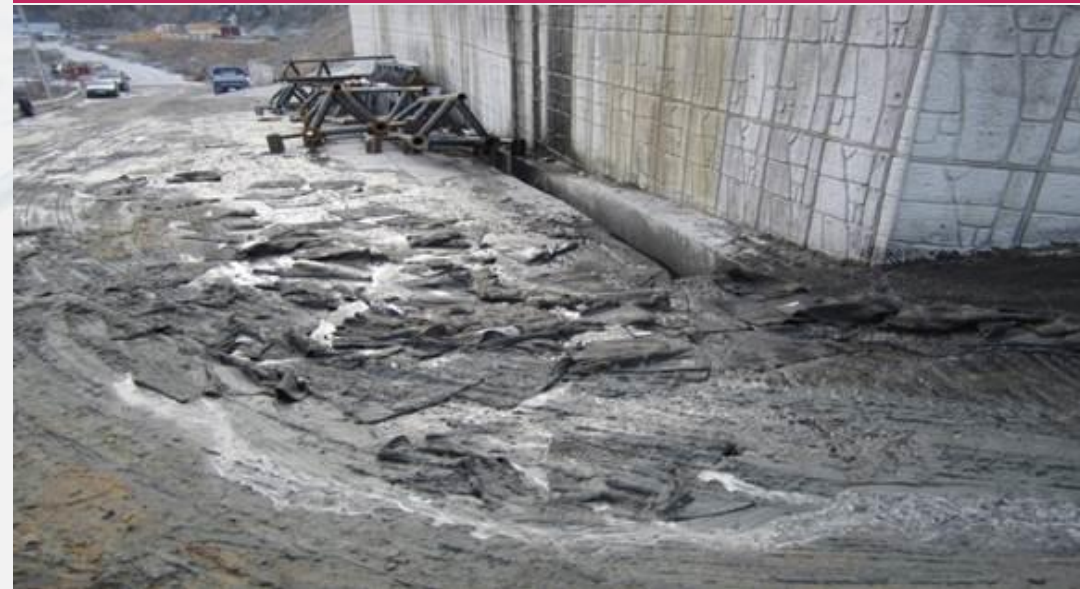
공장 진입도로 오염사진
