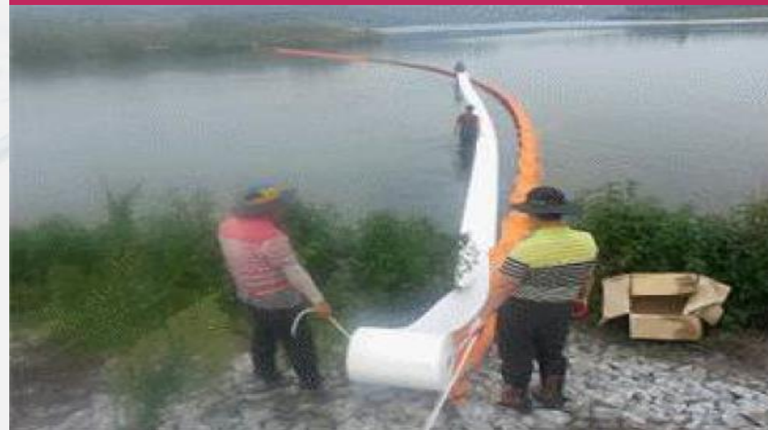
낙동강 합류전 오일펜스 및 흡착롤 설치
