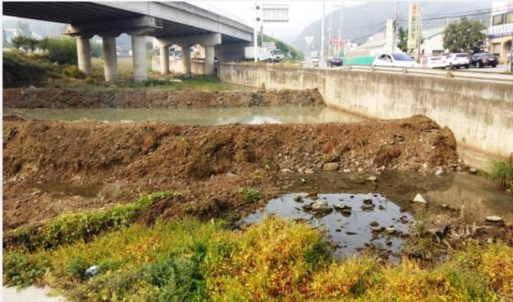
방제둑 설치(1km, 2.2km)
