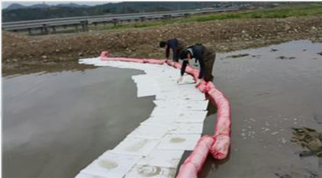
농수로 유출부 오일뿔 및 흡착포 설치
