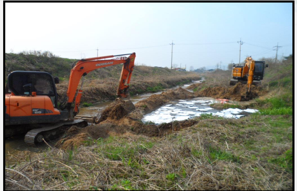
중장비를 활용해 방제둑 설치
