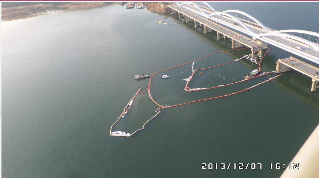
3중 오일펜스 설치
