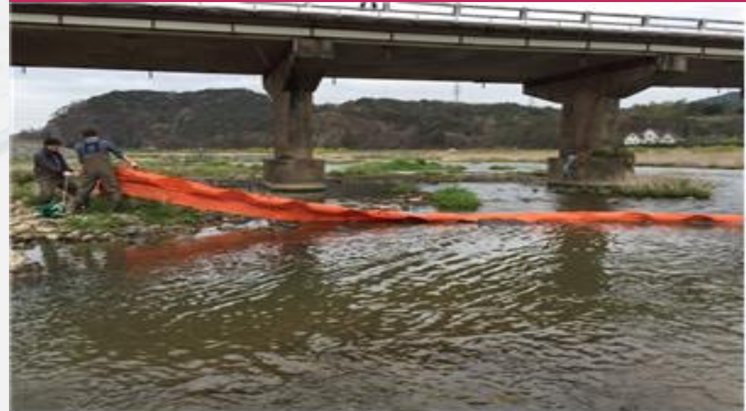
지석천 합류지점 오일펜스 설치
