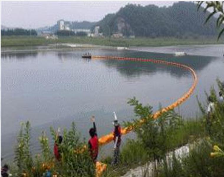
낙동강 본류 오일펜스 설치
