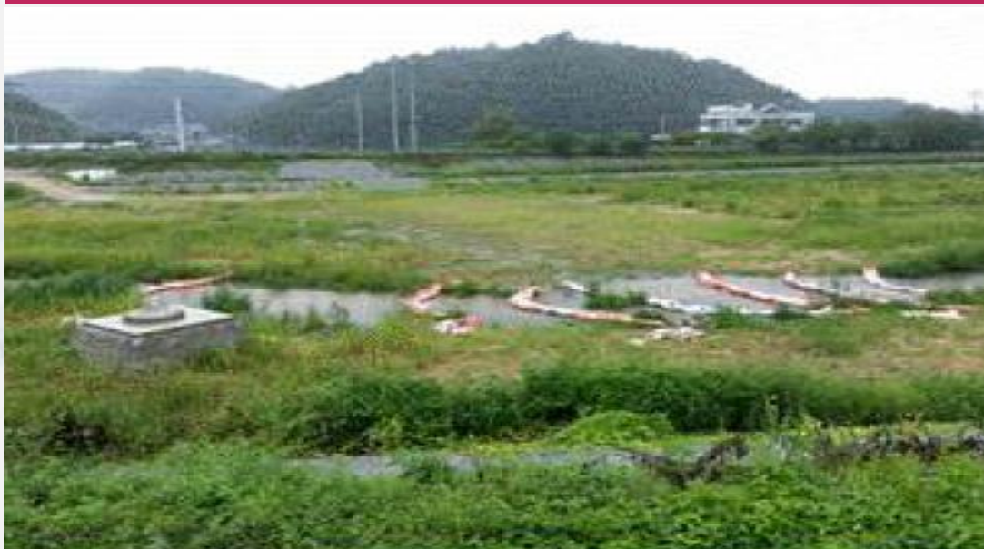
본류 합류전 지류내 오일붐 설치
