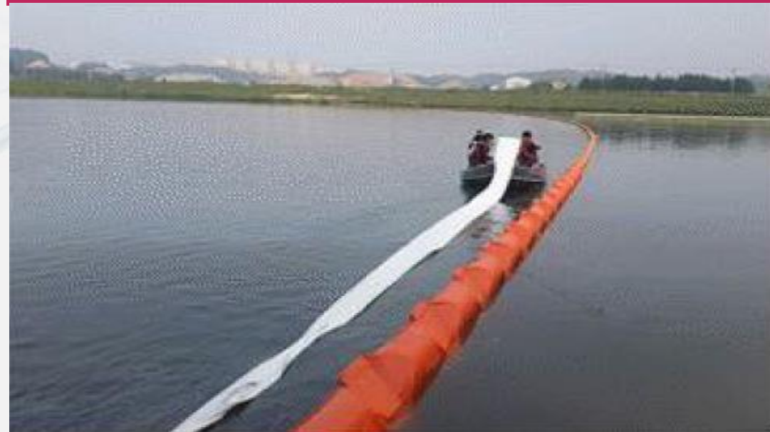
오일펜스내 흡착롤 설치
