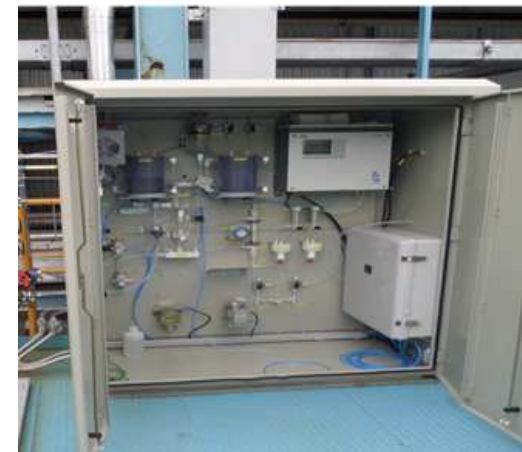
전처리 시설 및 수소 분석기 설치
