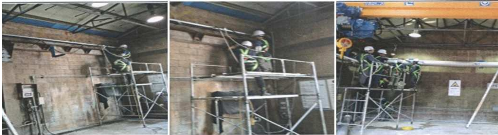
<국소배기장치 배관 설치공사 전경>
