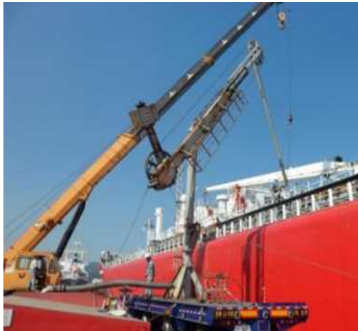
크레인을 이용한 선박 연결작업
