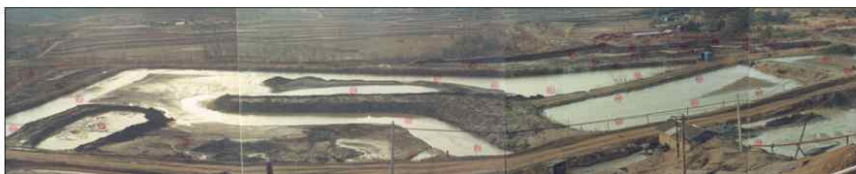
[그림 4.6] 광미침전지 차단벽 설치
