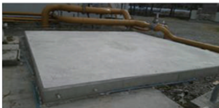
〈2차 증설용 습식탈황설비 기초설치〉
