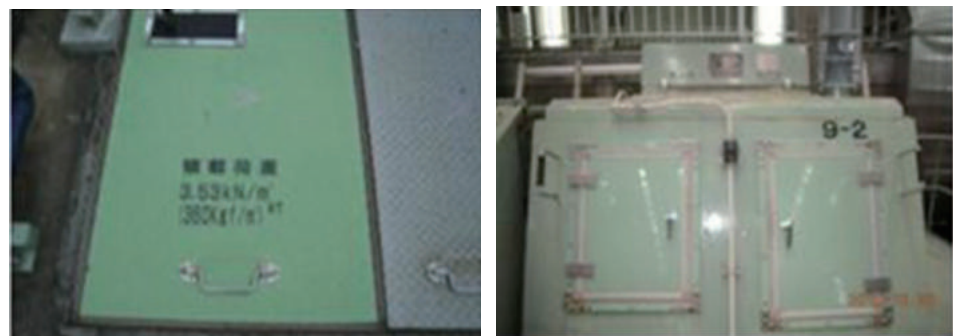
[그림 4.2] 오퍼아이 하수처리시설의 완전 밀폐식 맨홀 및 덮개 방식
