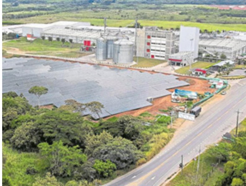
〈공장 옆에 설치된 태양광 패널〉
