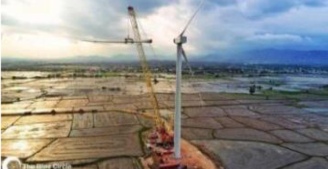
현재 캄보디아에서 건설 중인 BLUE CIRCLE 풍력발전 터빈
