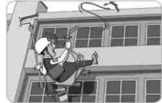
달비계를 사용하여 건물 외벽 청소시 구멍줄 미설치
