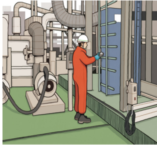
GAS 누출 여부 측정
