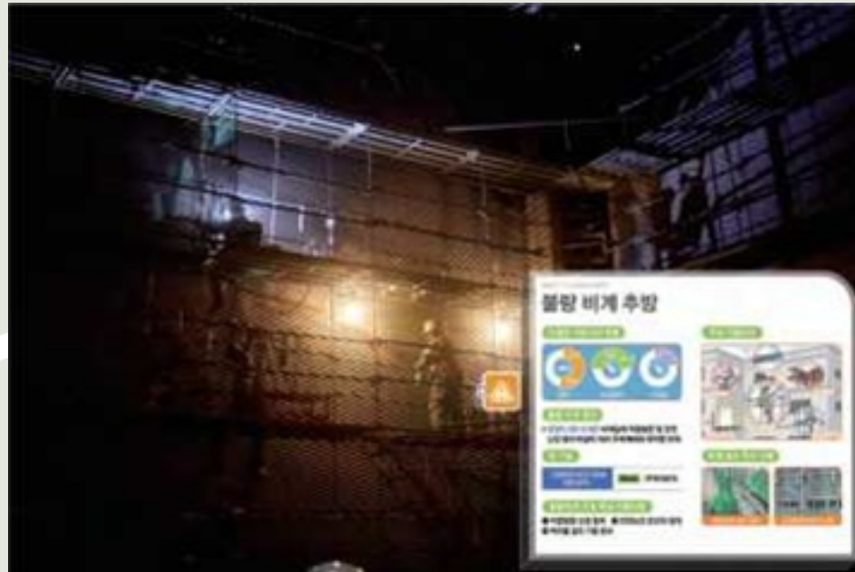
보일러 내부 비계작업
