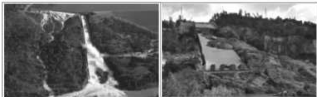
그림 2-1-2-12 美 Oroville Dam 사고사례
