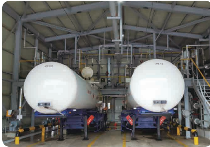
[사고가 발생한 염소하역장]
