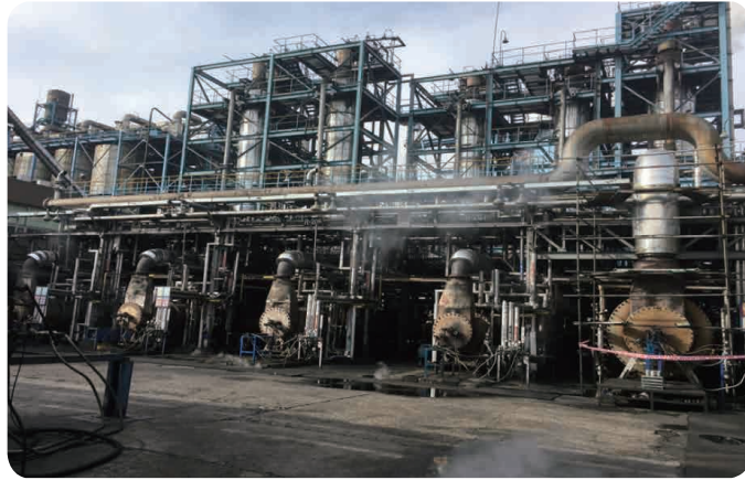
[사고가 발생한 카본블랙 공장]
