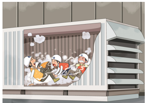
- 냉각탑 내부 내장재(충전재) 교체 작업을 하던 중 냉각탑 내부로 유입된 질소에 의해 질식 4명 사망
