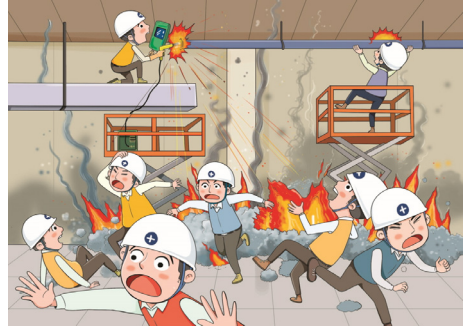
- 건물지하 설비공사현장에서 다수 하청근로자가 동시 작업 중 용접불티에 의한 화재 8명 사망
