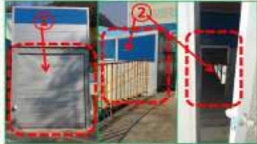
출입문 2중화 시설 (개선 후)
