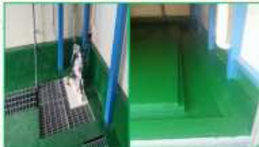
Trench/Pit/폐수이송시설 (개선 후)
