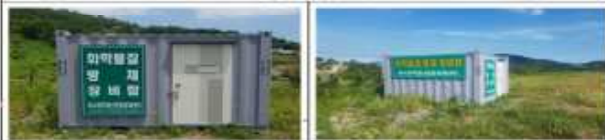
설치 현장 (모도교차로)
