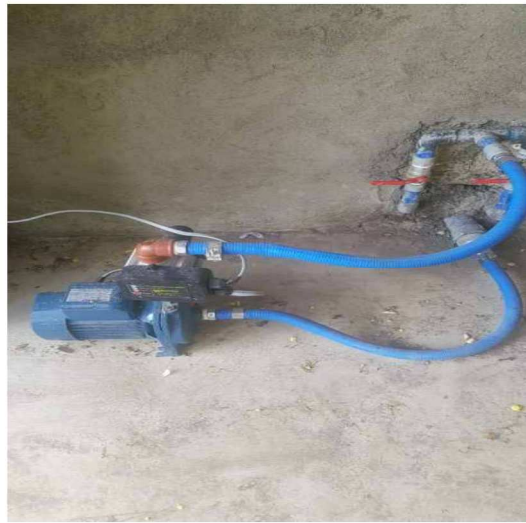
급수 펌프 설치 완료
