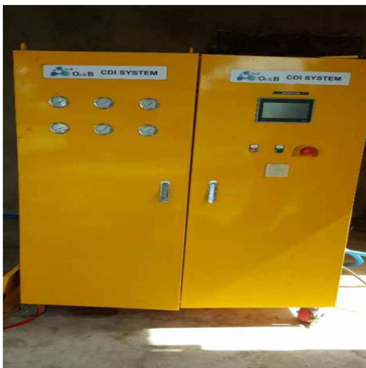
최종 설치 완료
