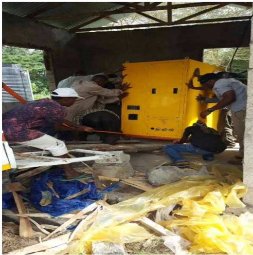
정수장치 설치 현장 운송 완료
