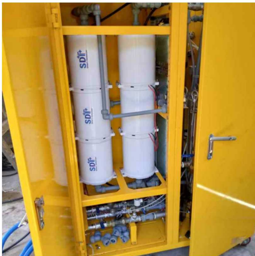
최종 배관 설치 완료
