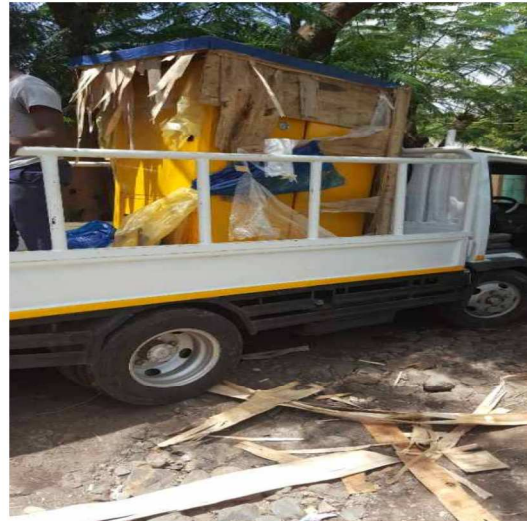
정수장치 설치 현장 운송 완료
