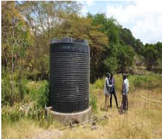
설치지역에 공급되는 배수탱크 (10톤)
