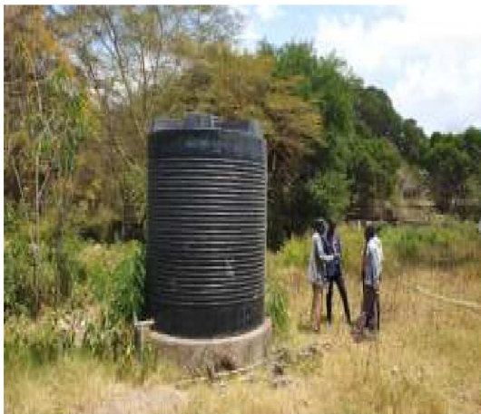
설치지역에 공급되는 배수탱크 (10톤)
