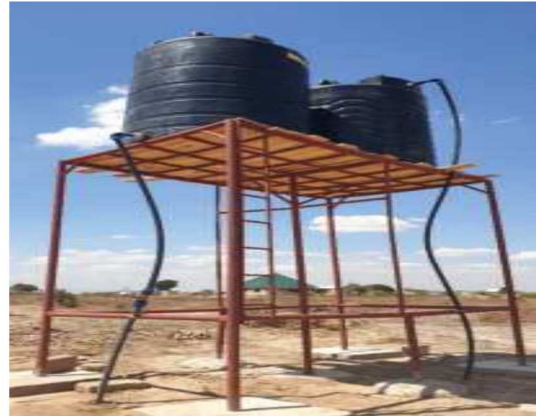
물탱크 5톤짜리 2개를 설치하여 공급
