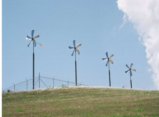
그림3. 오염지하수의 기름 제거를 위해 활용되는 풍력발전설비 출처: A Citizen's Guide to Greener Cleanups, EPA, 2012.
