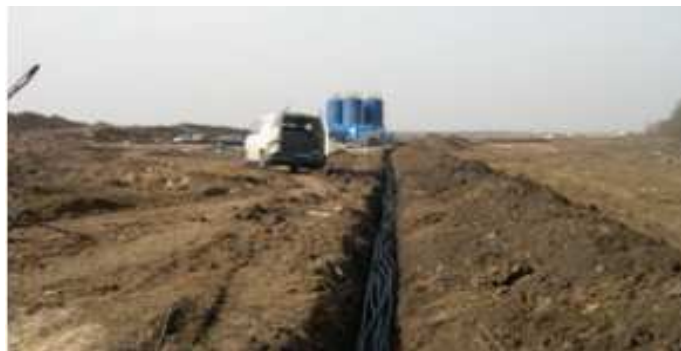
그림11. 생물학적 정화 이송관 매설 현장 출처: 농어촌연구원, 2013.
