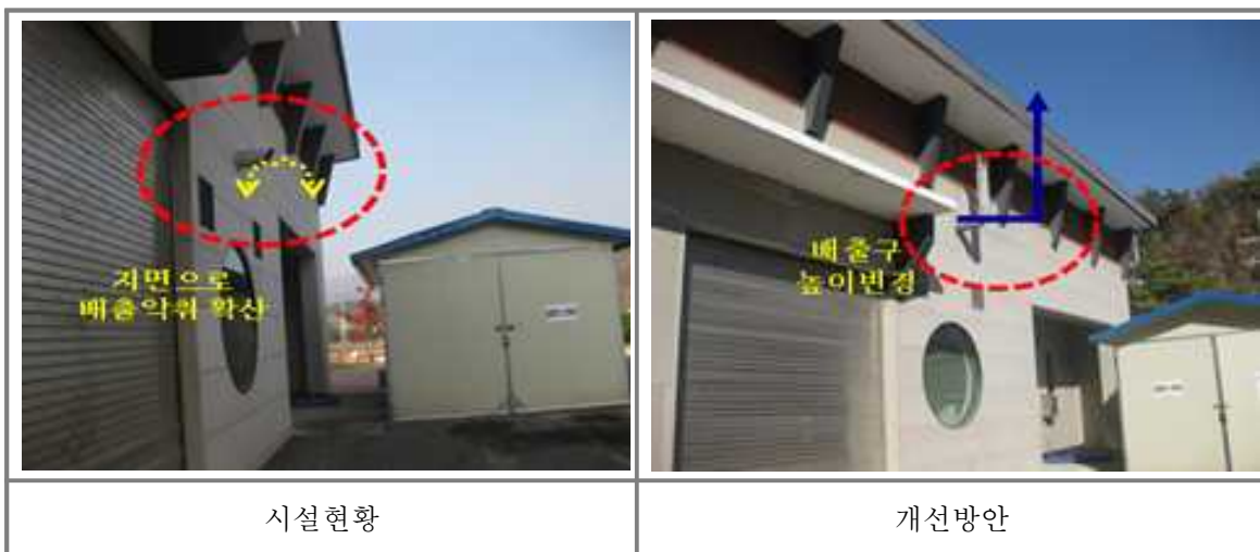
<그림 2-48> 악취방지시설 배출구 설치지점 변경
