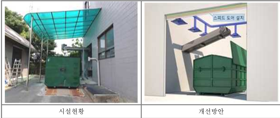
<그림 2-45> 탈수케이크 저장실 신설 및 포집설비 설치
