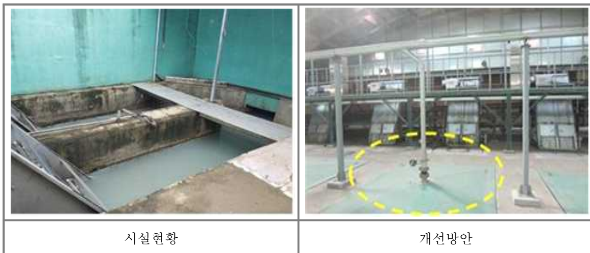
<그림 3-32> 침사지 수로 밀폐 및 악취포집설비 신설
