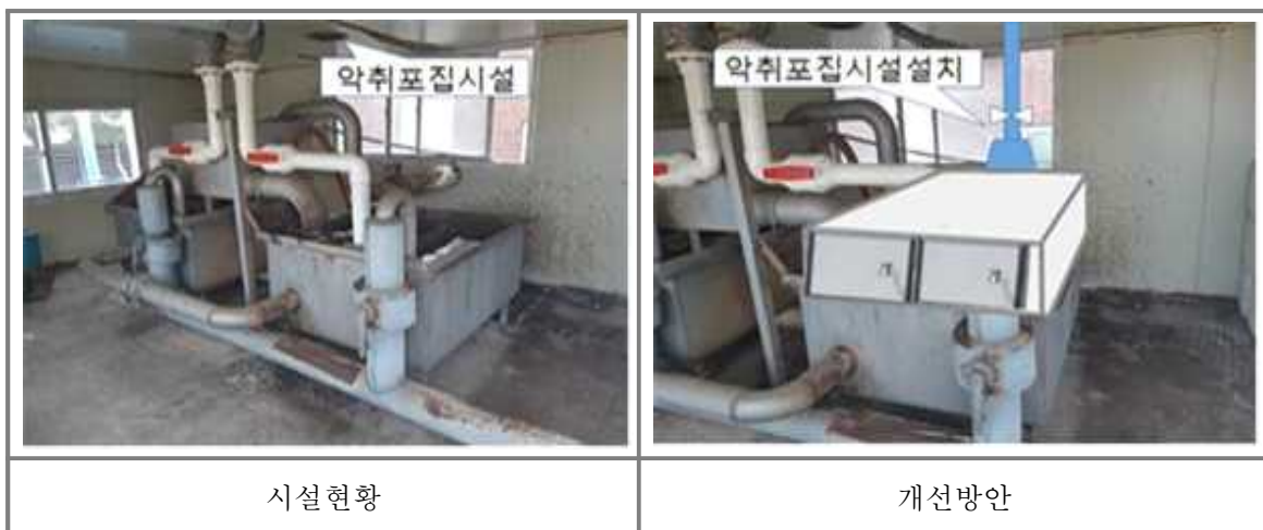
<그림 4-28> 원수분배조 상부 덮개 및 악취포집설비 설치
