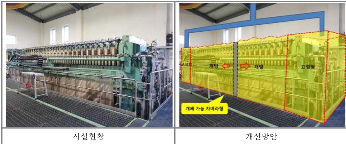
<그림 3-35> 탈수기 구획화 및 악취포집설비 개선
