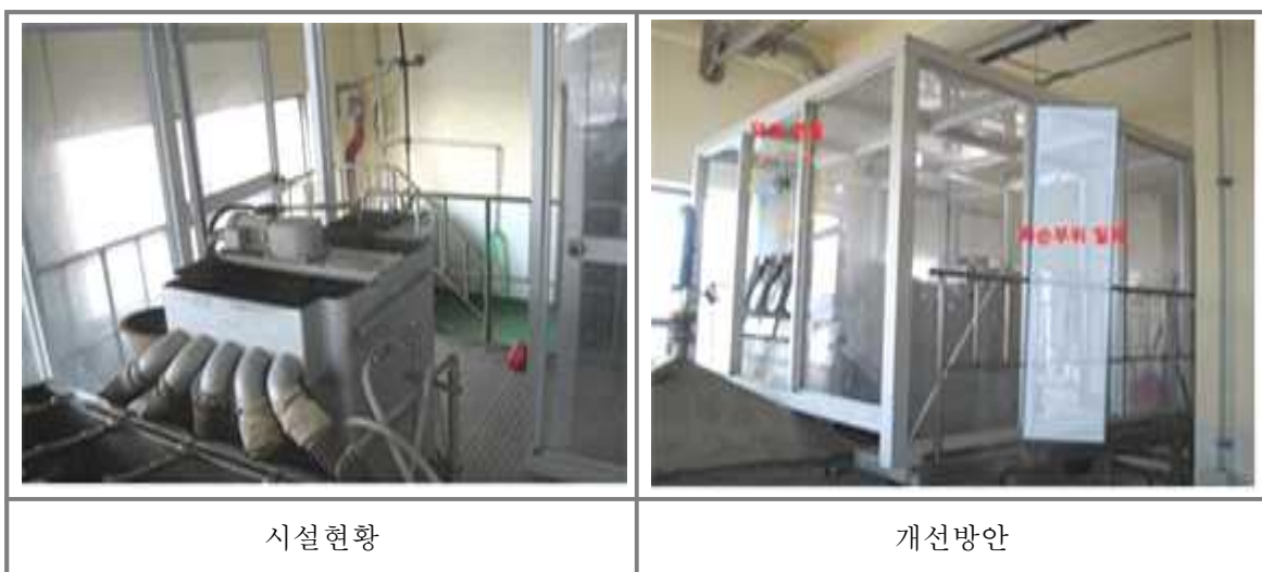
<그림 2-46> 탈수기 구획화 및 포집설비 설치
