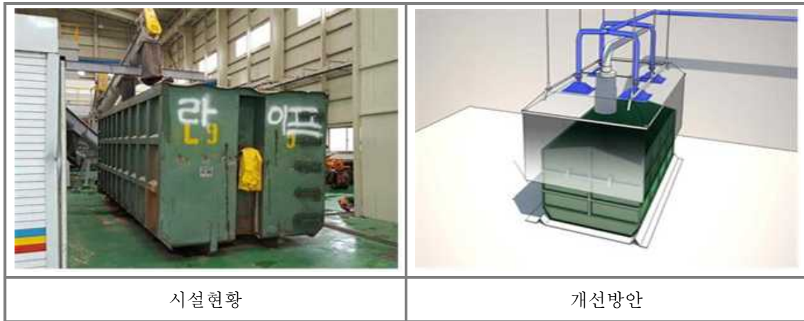
<그림 6-27> 투입호퍼실 개폐형 구조로 시설 개선
