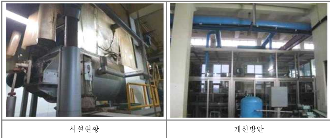
<그림 7-18> 슬러지건조기 주변 구획화 및 악취포집시설 설치
